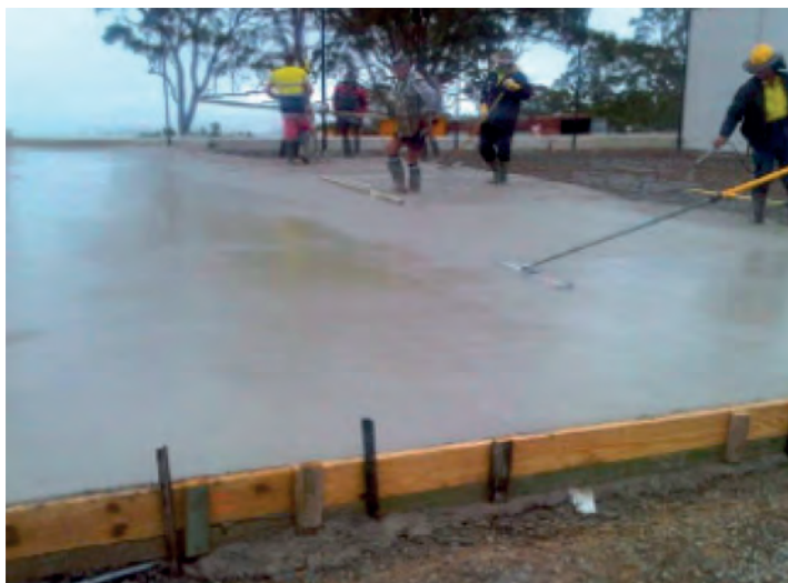
Rys. 6. Płyta boiska do tenisa wykonana z betonu geopolimerowego
