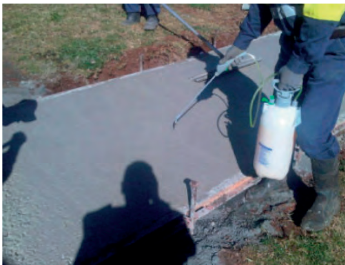
Rys. 7. Chodnik w mieście Toowoomba w Australii wykonany z betonu geopolimerowego
