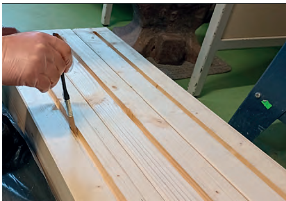
Rys. 6. Aplikacja warstwy gruntującej żywicy w brzdach za pomocą pędzli
