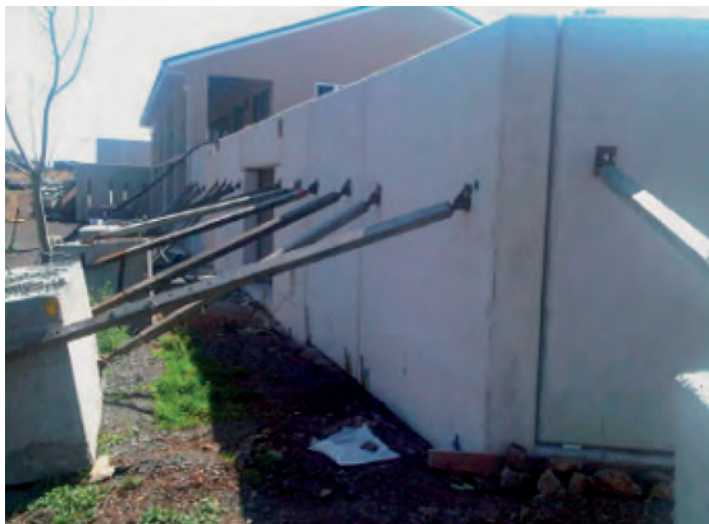
Rys. 8. Panele ścienne osłonowe wykonane z betonu geopolimerowego
