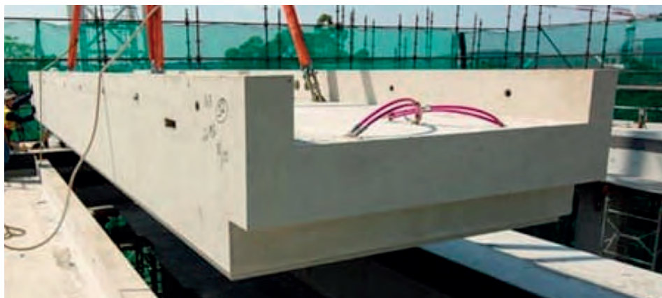
Rys. 3. Płyta prefabrykowana – części posadzki z betonu geopolimerowego
